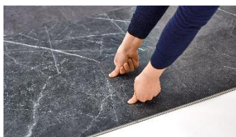
5. 短辺の両端を親指で 「カチッ」と音がするまで 押し込む。
