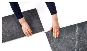
6. 完全に外れるまで、平行にスライドさせ続ける。
