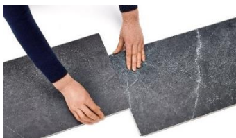
5. スライド中は、ねじれないように板を軽く押さえ、必ず 平行にスライド させる。
