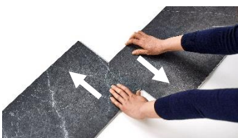
4. 短辺側を外すには、双方の板を 反対方向にゆっくりとスライド させる。
