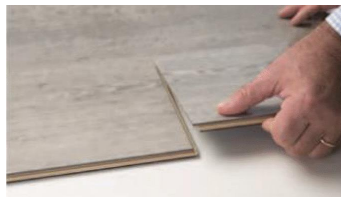
2. 隣の板の短辺に当たるまでスライドさせ、ゆっくり落とす。
